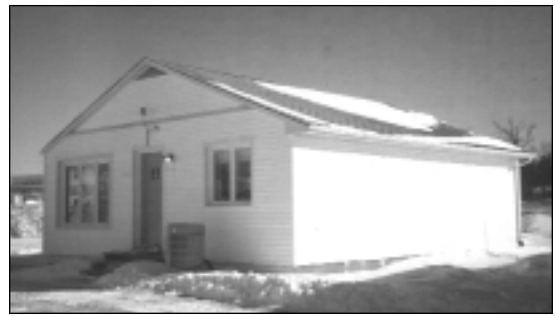
Figure 4. Maison expérimentale n°1 de l'IRC avec la partie du sous-sol hors-terre visible
