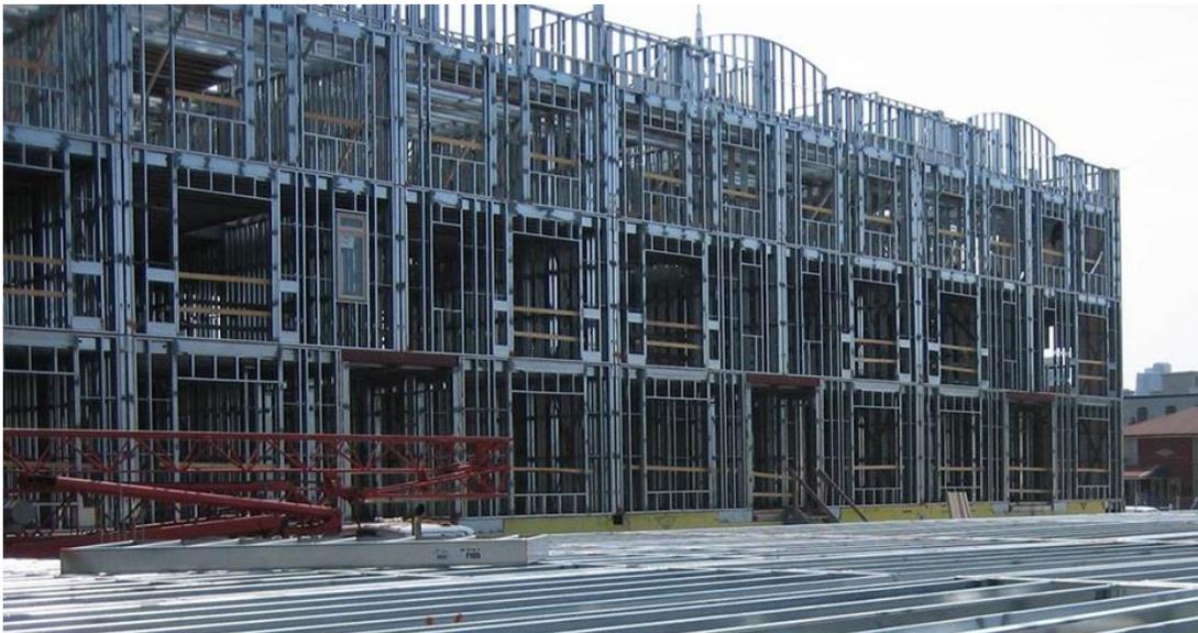
**Figure B.16 : Bâtiments en acier formé à froid (AFF) (image tirée de BuildUsingSteel, 2018)**
