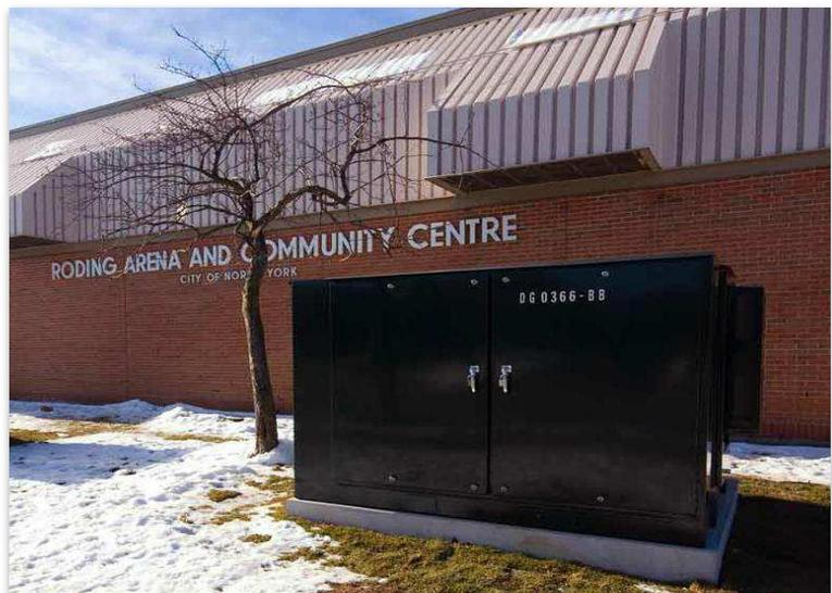
Figure 1 – Système de stockage énergétique communautaire de 250 kWh eCAMION, déployé sur le réseau de Toronto Hydro
