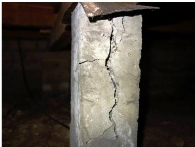
**Figure E.6 : Grandes fissures dans le béton**
