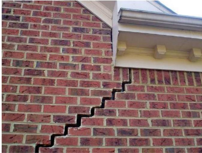
**Figure E.7 : Fissures en « marches d'escalier » dans les murs en maçonnerie**
