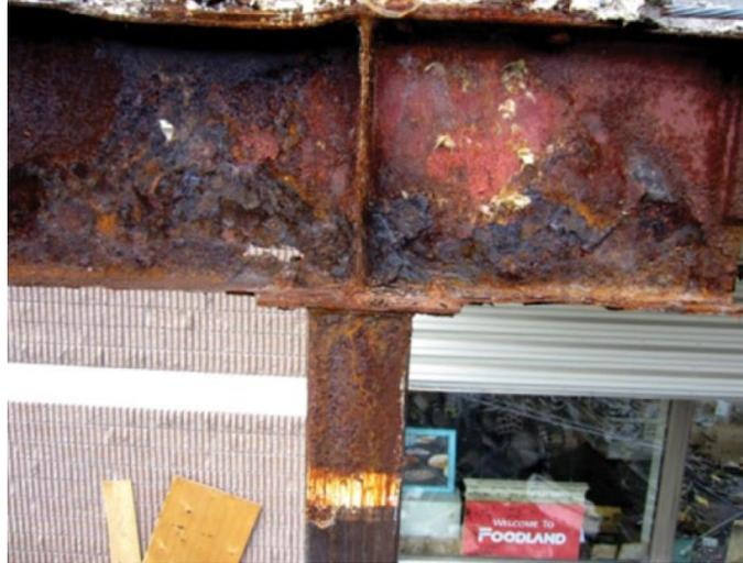
**Figure E.3 : Profilé d'acier et connexions soudées et corrodées (Bélanger, 2014)**
