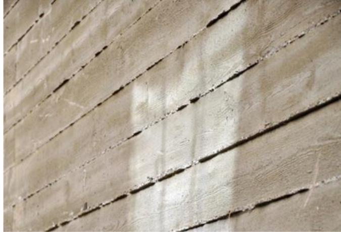
**Figure C.6 : Béton coulé sur place avec motif de bois de coffrage**
