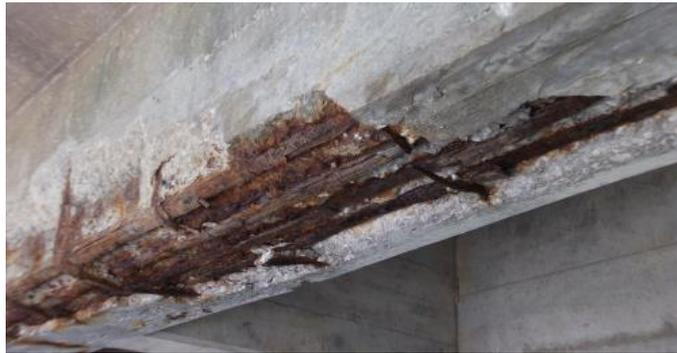
**Figure E.5 : Acier d'armature apparent**
