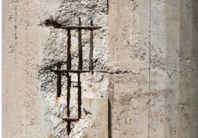
**Figure E.4 : Couche de béton effritée**
