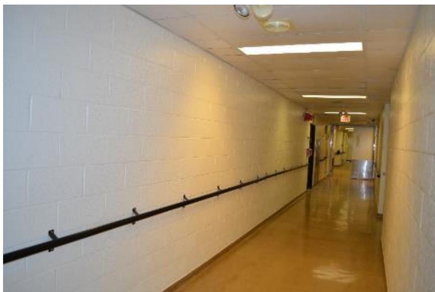
**Figure 5.21 : Cloison de séparation en maçonnerie dans un bâtiment présentant un danger potentiel de chute à l'intérieur**
