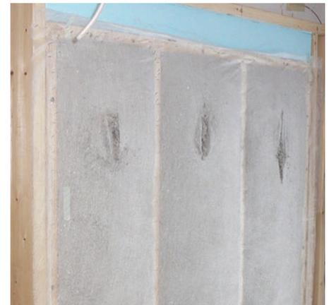
W3 avec cavité murale remplie d'un isolant de cellulose de 12 po
