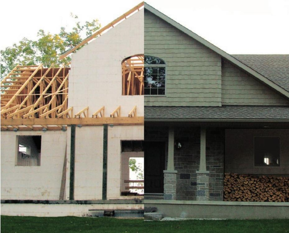
Vue d'une maison construite avec des coffrages à béton isolants pendant et après la construction
